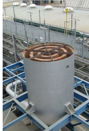
ภาพที่ 2-6 อุปกรณ์ดูดซับเสียง (Silencer)
