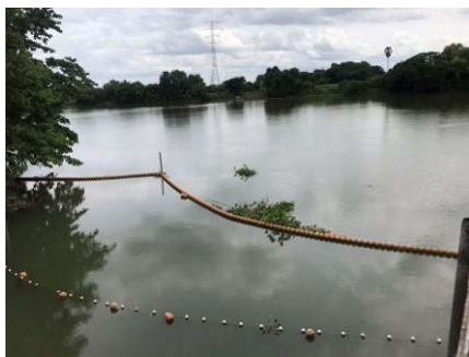
ภาพที่ 2-22 ตะแกรงป้องกันสัตว์น้ำและเจ้าหน้าที่ดูแลตลอด 24 ชั่วโมง เพื่อตรวจสอบความผิดปกติก่อนสูบน้ำที่สถานีสูบน้ำโรงไฟฟ้าราชบุรี
