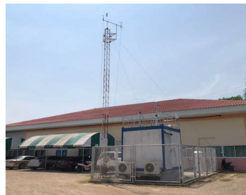
ภาพที่ 2-3 ระบบติดตามตรวจสอบการระบายมลพิษอย่างต่อเนื่อง (CEMs)
